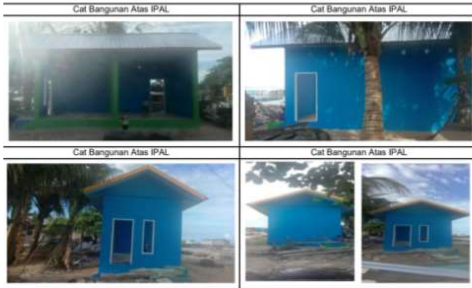
Pembangunan IPAL di Kelurahan Pantai Amal
