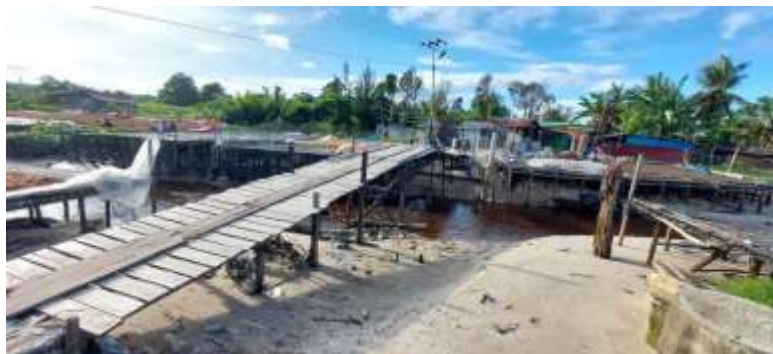
Pembangunan 0% Jembatan RT 11 Binalatung Amal
