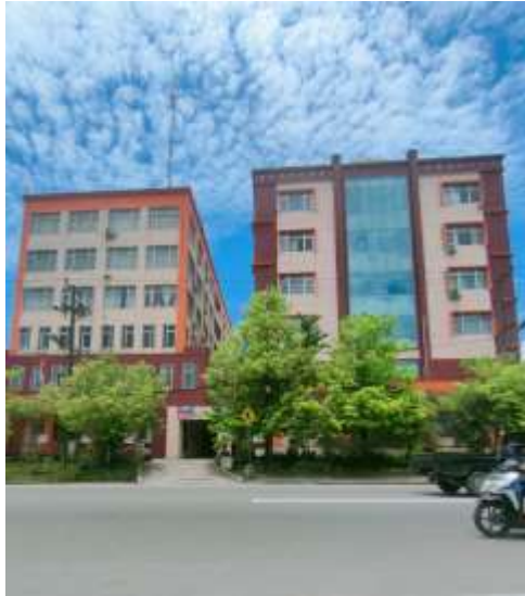
Rehabilitasi Gedung Gadis
