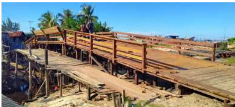
Pembangunan 100% Jembatan RT 11 Binalatung Amal
