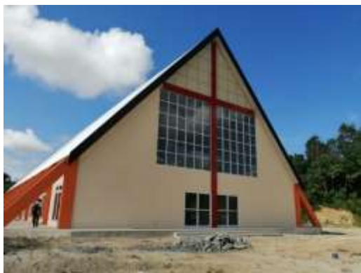
Pembangunan Gedung FKUB
